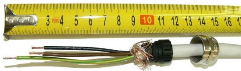
рис. 8 – присоединение кабелей к клеммам
