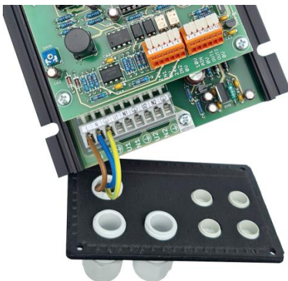
Abb. 5 – Demontage des Teils mit Durchgängen
