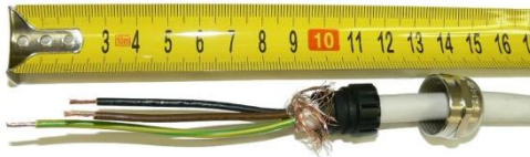
Abb. 8 - Anschluss der Leiter an die Klemmen
